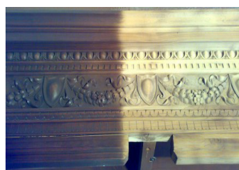
RIPRISTINO PORTE, FINESTRE E MOBILI
